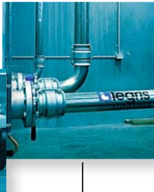
Gama Transair: sistemas de distribución de aire e agua para naves industriales
